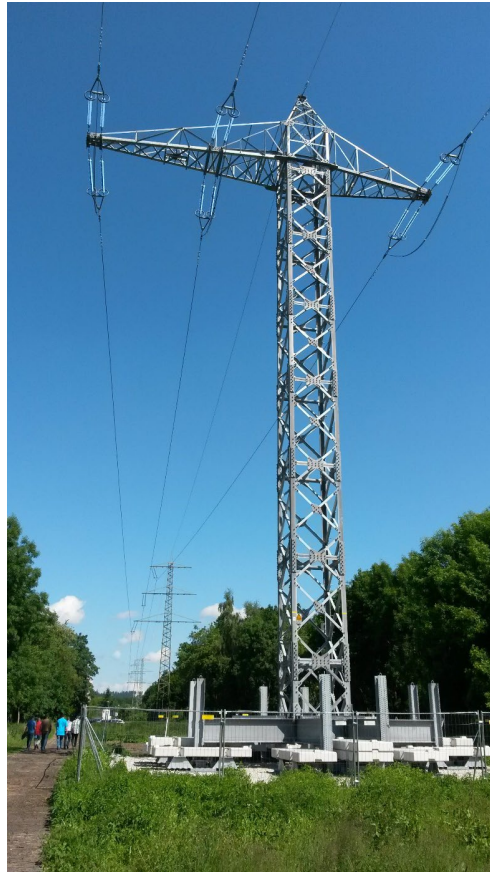
Abbildung 2: Darstellung Mast Auflastprovisorium (Quelle Amprion)
