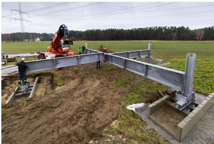
Abbildung 3: Auflastprovisorium - Mastfuß mit Schotterbetten (Quelle Amprion)
